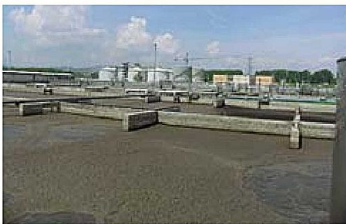
Il depuratore L'impianto di San Colombano
